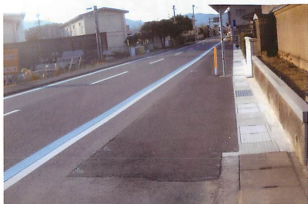
◇平成29年 県道三瓶線 RIC工場前水路工事 中畑議員にお願いして完成
