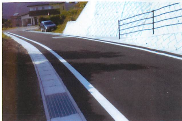
◇平成28年 常定寺 お寺下市道新設工事
