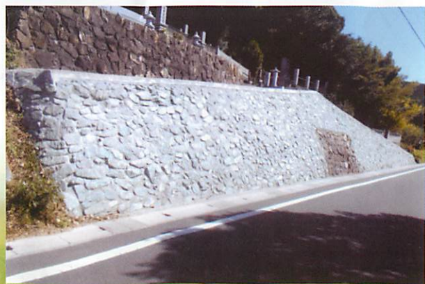
◇平成28年 下松葉 よう壁工事
