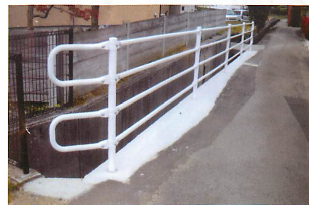
◇平成30年 上松葉 ガードパイプ工事
