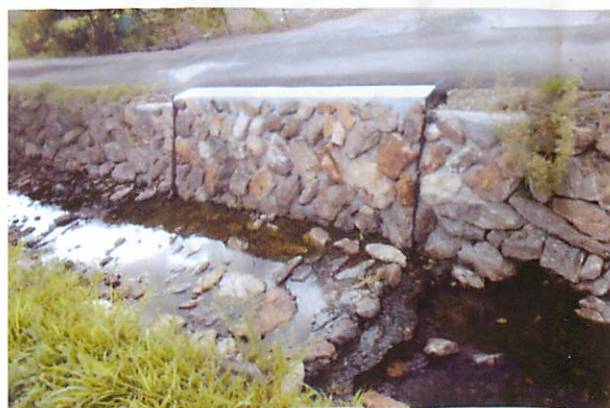
◇平成29年 西山田 永田川よう壁工事
