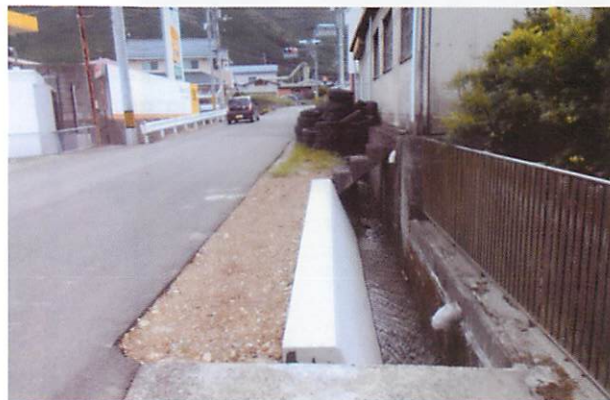
◇平成29年 下松葉 上宇和駅東水路よう壁工事
