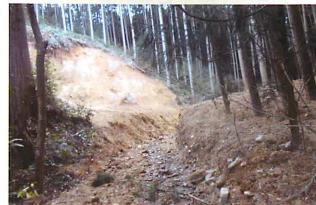
◇平成30年 清沢 砂防土砂くずれ整地
