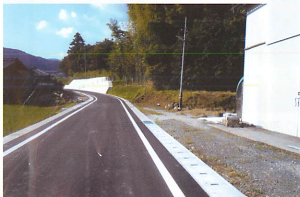
◇平成28年 常定寺 市道新設工事
